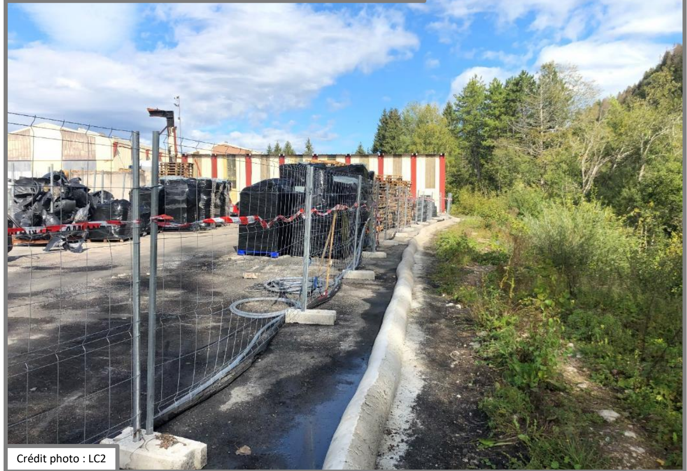
Chantier mis sous rétention – SS3
