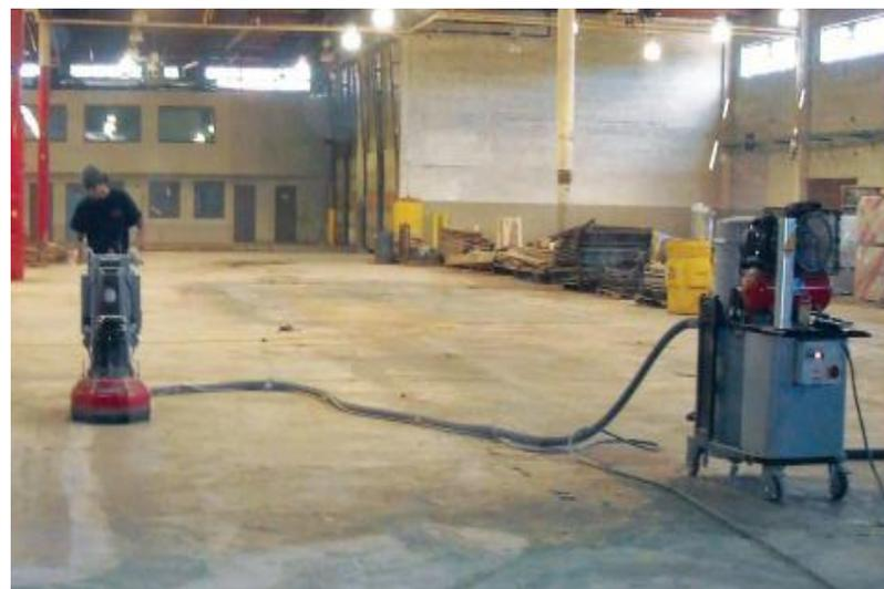
Balayeuse à l'humide avec captage à la source et filtration
