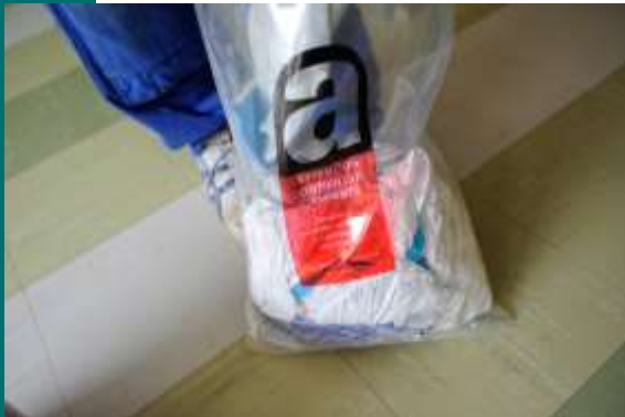
Sac pour EPI amiantés
