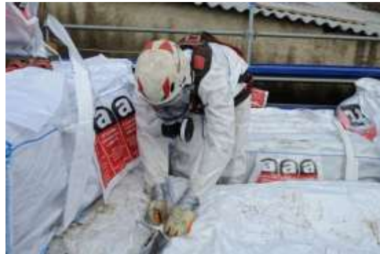
Dépôt bag amiante
