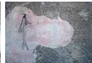
Crépi et enduit 18
