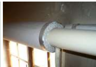
Calorifugeage
