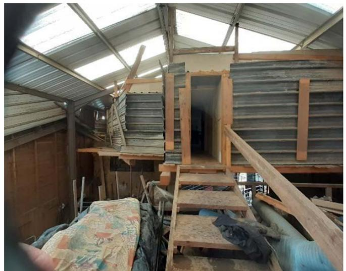
plaques de fer, elle était posée en équilibre sur des poutres soutenues par des étais de chantier, l'installation électrique n'était pas aux normes et l'accès non sécurisé.
