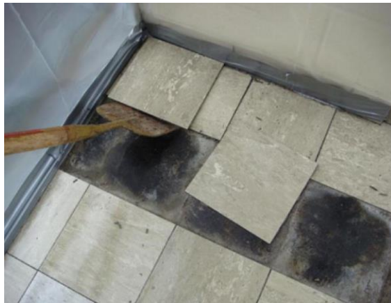
Remplacement d'une ou 2 Dalles de vinyle amiantées
