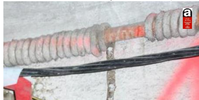
Intervention sur calorifugeages amiantés (en haut carton, en bas tresse)
