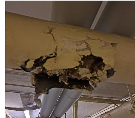
Rafistolage d'un calorifugeage
