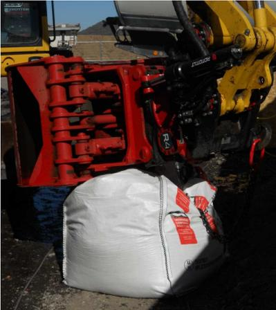
**Fines de balayage reprises à la pelle hydraulique et conditionnement en GRV.**
