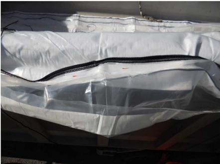
Utilisation de "Body-benne" de type « TP liner » double ensachage avec fermeture zippée.
