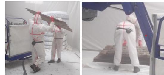
Autre exemple : Dépose par le dessous de plaque en fibrociment :
