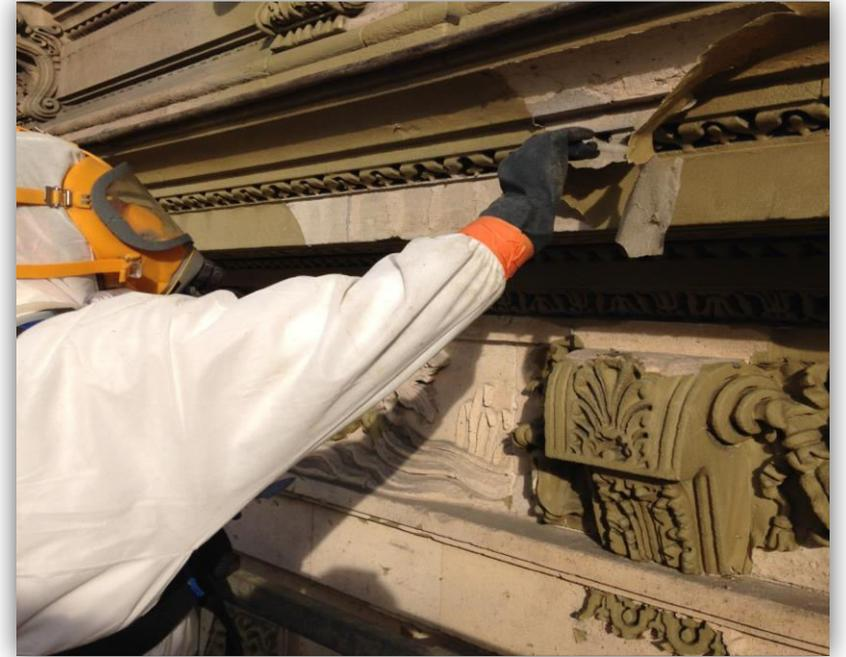
Nettoyage d'une façade à l'aide de latex ou de cataplasme, alternative au sablage, l'hydrogrommage
