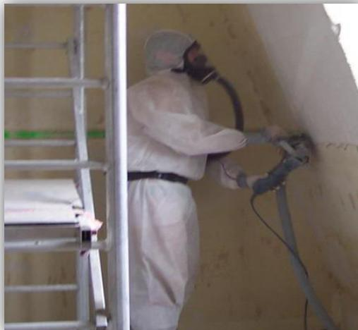
**Ponçage de peinture avec une ponceuse reliée à un aspirateur de classe H selon la norme NF EN 60335-2-9**
