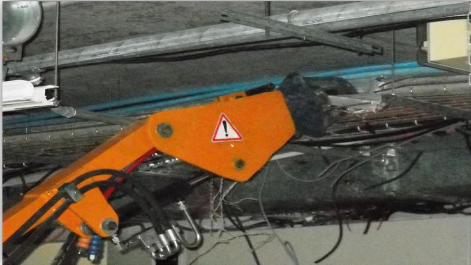
Utilisation d'une pince hydraulique, alternative à la découpe au chalumeau
