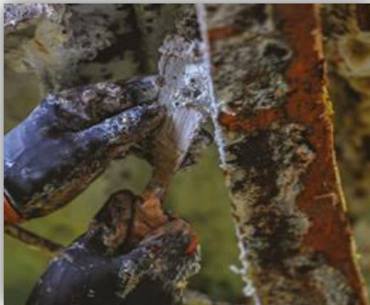
Décapage chimique d'une peinture au plomb, alternative au sablage, piquage ou grattage
