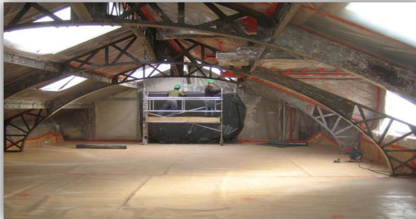
**Utilisation d'une aspiration centralisée afin de ramasser des résidus de sablage**
